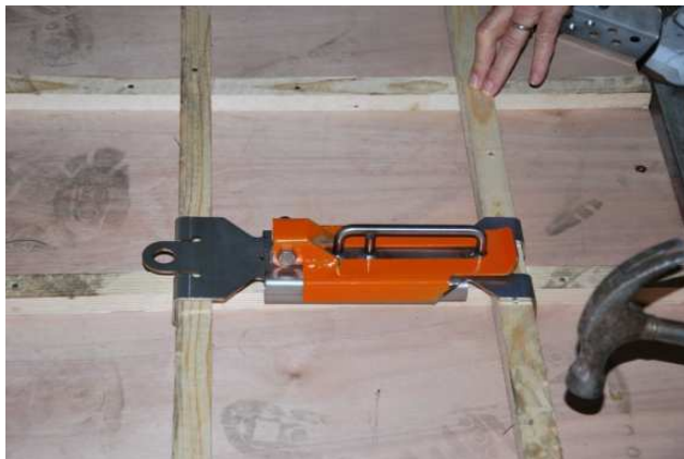
Afb.2 Positioneringsapparaat, onderdeel Dakhaas
